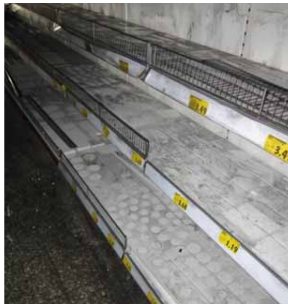
Bild 3-2: Schadenbeispiel Rauchschaaden in der Lebensmitteldistribution; Bild zeigt Verkaufsräume nach Entsorgung der Ware.
