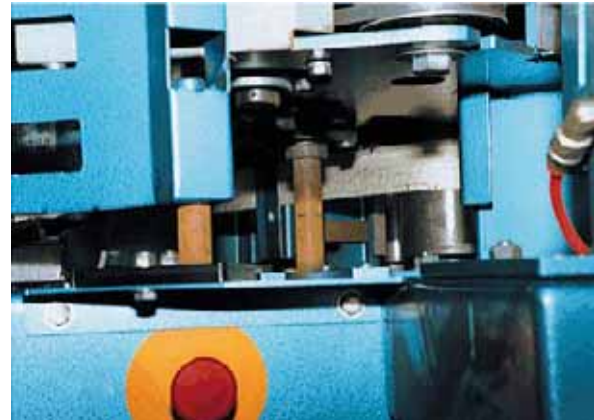
Bild 2-3: Rauchschäden und beginnende Korrosion an einer Maschine nach einem Brand. (Bild: Schaden 2/1997, © IFS e. V.)
