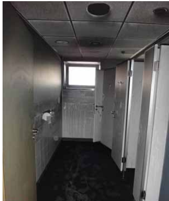
Bild 5-9: Beispiel für die Ausbreitung von Rauch durch eine Lüftungsanlage. Trotz eines nur sehr kleinen Brandherdes (Papierkorb in einem Büro) wurden alle weiteren durch die Lüftungsanlage versorgten Räume erheblich kontaminiert.
