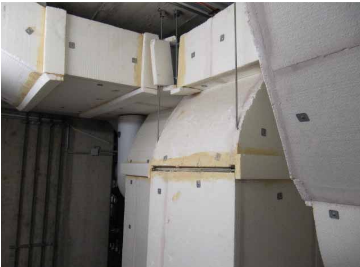
Bild 5-12: Wärmedämmung von Lüftungskanälen aus brennbaren Baustoffen (hier aus Polystyrol). Aus brandschutztechnischer Sicht sollten nur nichtbrennbare Materialien eingesetzt werden.
