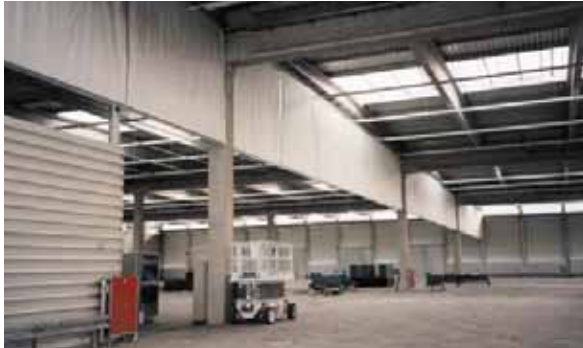
Bild 5-6: Zur horizontalen Begrenzung der Rauchausbreitung werden Rauchabschnitte durch abgehängte Rauchschürzen geschaffen (hier aus nichtbrennbaren Textilien).
