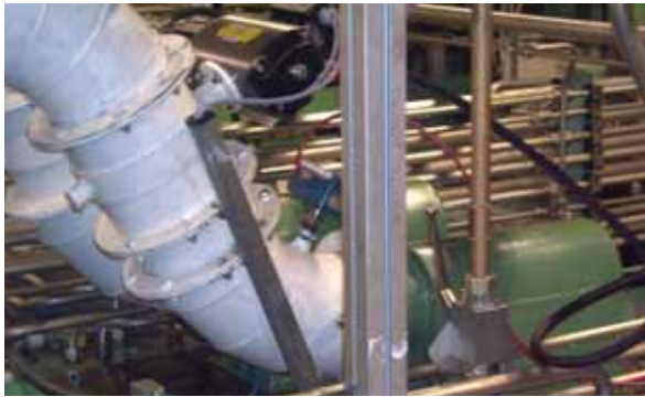
Bild 7: Schnellschließende Absperrklappe mit automatischer Auslösung (Quelle: Handte APC GmbH)
