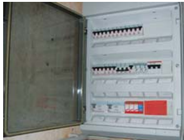
Bild 8: UV mit Überspannungsableiter Typ 2
