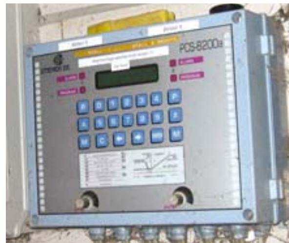
Bild 6: Alarmierungseinrichtung
