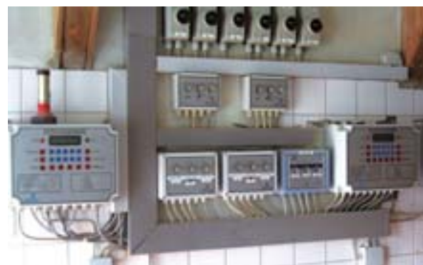
Bild 7: Lüftungsteuerung
