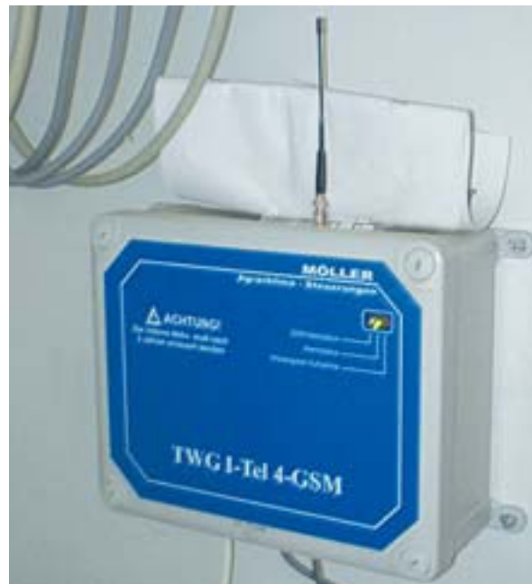
Bild 11: Telefonwahlgerät-Mobilfunknetz (GSM-Modem)
