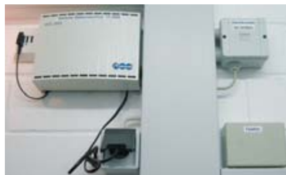
Bild 12: Telefonwahlgerät Festnetz
