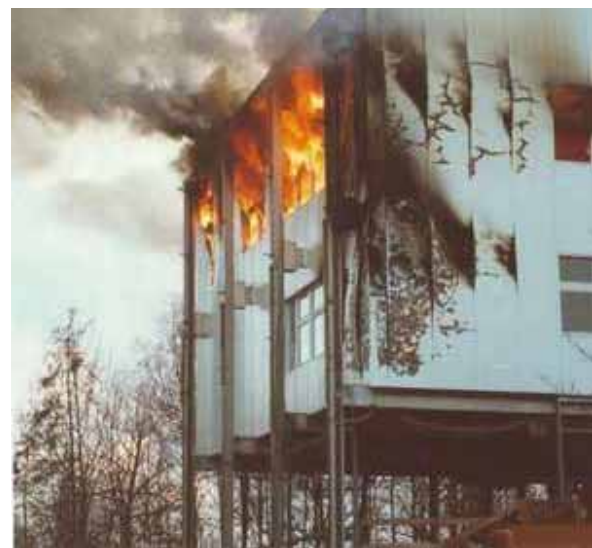
Abb. 6-1: Großbrandversuch mit PUR-Sandwichelementen als Außenbauteil
