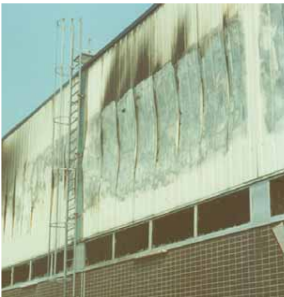
Abb. 6-3: Sandwichelemente nach einem Brand
