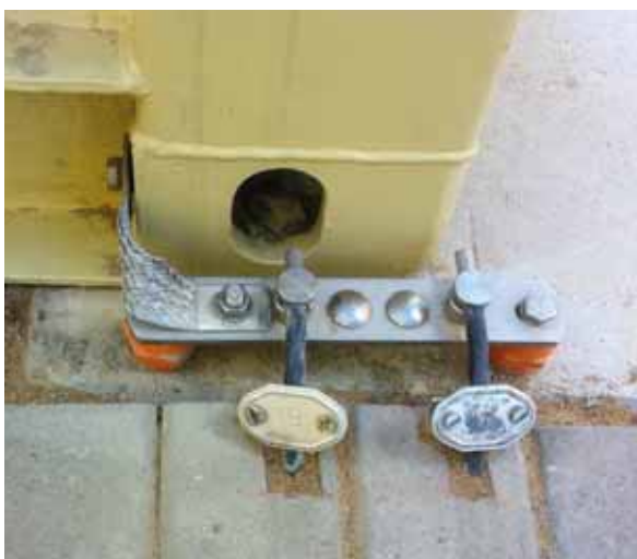
Bild 20: Einbindung von Anlagenteilen in den vermaschten Potentialausgleich
