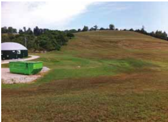
Bild 3: Biogasanlage am Fuß eines Hanges
