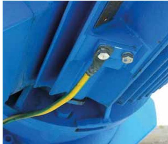
Bild 21: Potentialausgleich am Rührwerksmotor
