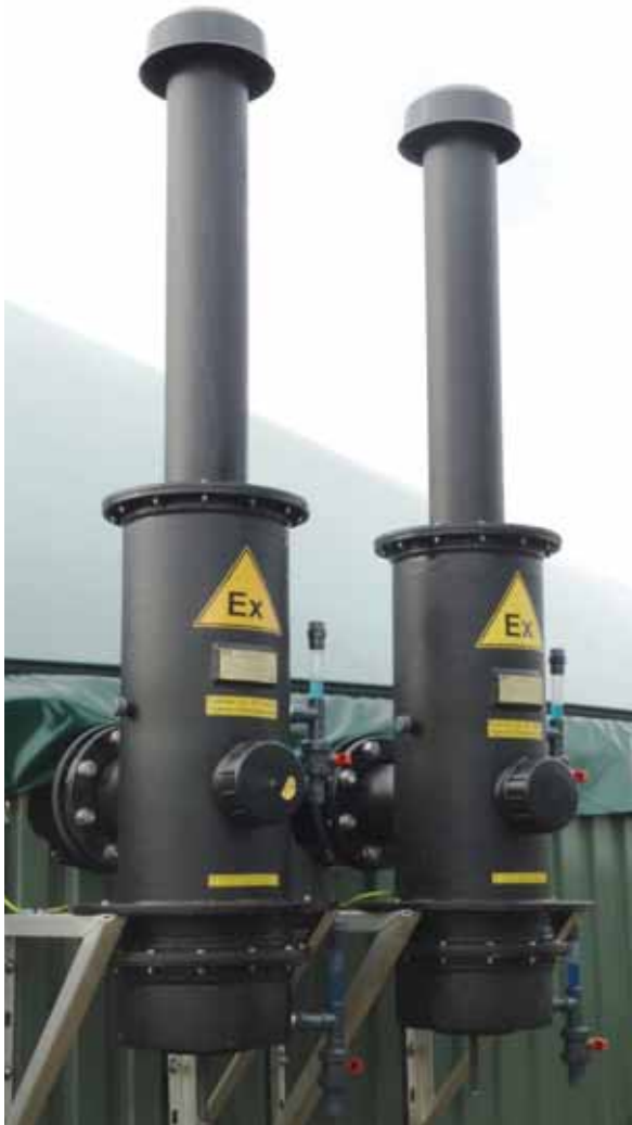
Bild 13: Überdrucksicherung
