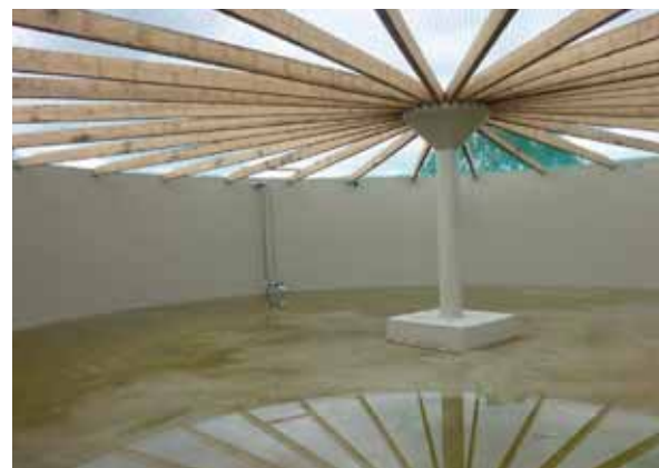
Bild 6: Holzkonstruktion im Nachgärer
