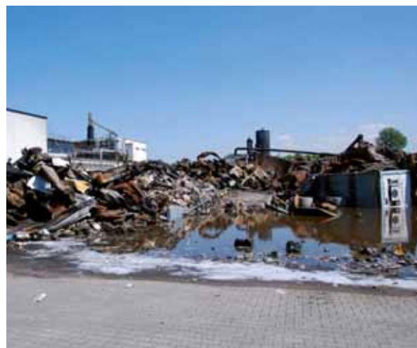
Abb. 12: Totalschaden – Eine Bratstraße nach einem Brand.
