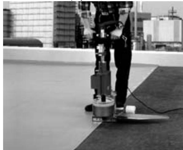
**Bild 6:** Wärmedämmung – mechanische Befestigung
