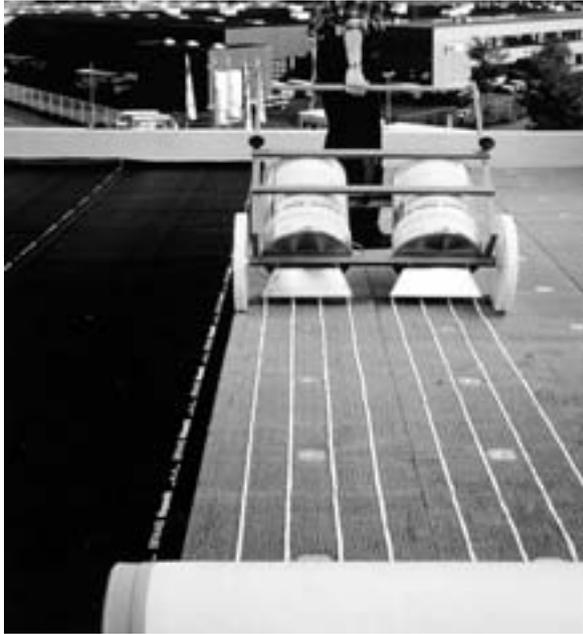
Bild 7: Wärmedämmung – Kleben
