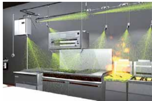
Abb. 1 Beispiel einer Kleinlöschanlage über einer Frittiereinrichtung
