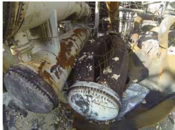
Bild A6-11: Aufgeplatzter Reboiler (Quelle: U.S. Chemical Safety Board (CSB); http://www.csb.gov/ )
