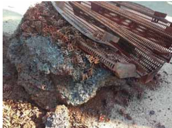
Bild A6-9: Die metallischen Füllkörper waren aufgrund der Hitze miteinander verschmolzen
