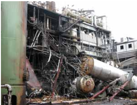
Bild A6-10: Zerstörtes Tanklager und angrenzendes Produktionsgebäude
