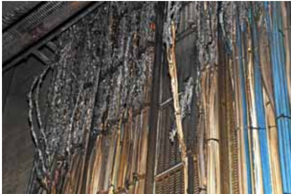
Bild A6-2: Bild eines Elektroverteilungsraumes
