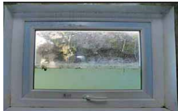
Abb. 8: Beispiel für ein wasserdicht ausgeführtes Fenster (Quelle: Modell Neptun Outside, Alpina Hochwasserschutzfenster GmbH, www.alpinafenster.de )
