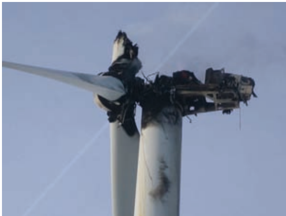
Abb. 2: Abgebrannte Gondel einer 1,5 MW-WEA (Bildquelle: Allianz)
