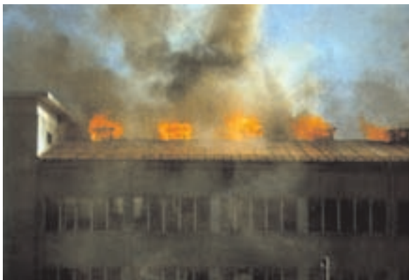
Abb. 2: Flammenüberschläge durch Dachdurchdringungen
