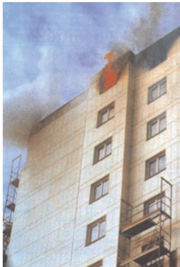
Abb. 3: Flammenüberschläge durch Öffnungen in Außenwänden auf die Dachoberseite
