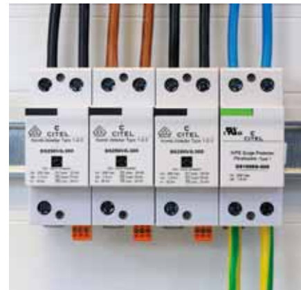
Installation im Verteiler (V-Verdrahtung)(Quelle: CITEL)
