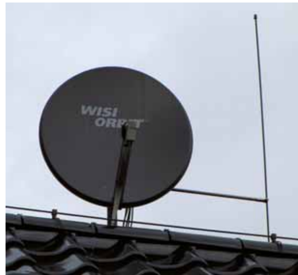
Bild 13: Gebäude mit Blitzschutzanlage
