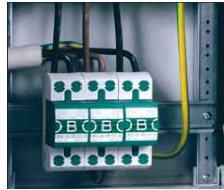
Installation im Verteiler (V-Verdrahtung) (Quelle: OBO Bettermann)
