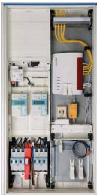
Bild 18: TN-C-S-System Vorzählerbereich, Realbild. Montage der Ableiter im Zählerschrank (links) oder im separaten Gehäuse (rechts). Auf den Ableiter zum N-Leiter wurde verzichtet, da die PEN-Aufteilung in unmittelbarer Nähe erfolgt (3+0-Schaltung) – entspricht Anschlusschema 1
