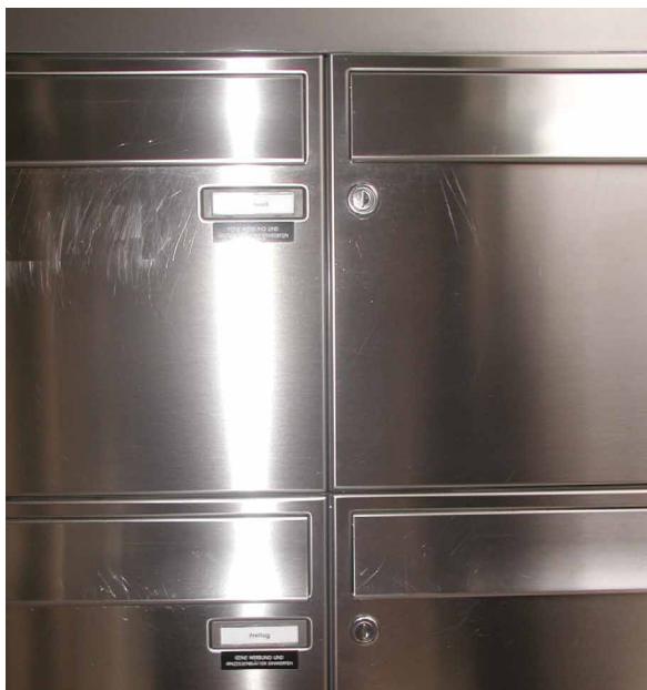
Abb. 10: Beispiel zerkratzter Oberflächen, Quelle: PLB Provinzial-Leben-Baubetreuungs-GmbH, Düsseldorf
