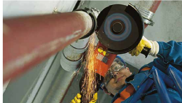
Abb. 13: Funkenbildung bei der Trennschneidarbeit, Quelle: http://www.infopool-bau.de
