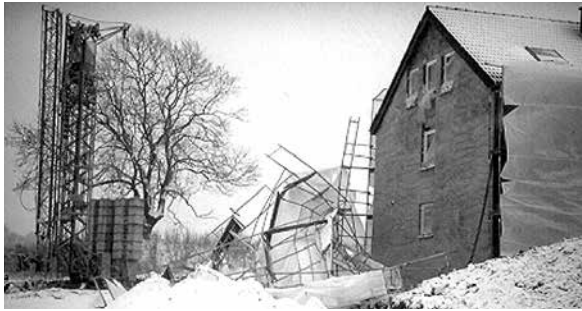
Abb. 8: Gerüste nach einem Wintersturm, Quelle: VdS 2389
