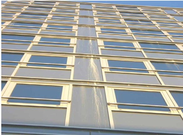
Abb. 15: Beispiel einer Verätzung an der Fassade eines Bürogebäudes, Quelle: Sachverständigenbüro Dipl. (FH) Eberhard Achenbach, Wardenburg
