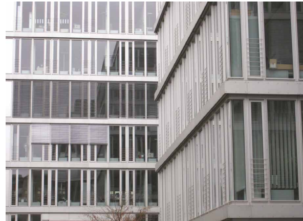
Abb. 11: Beispiel vollflächig verglaster Fassade, Quelle: M. Wang
