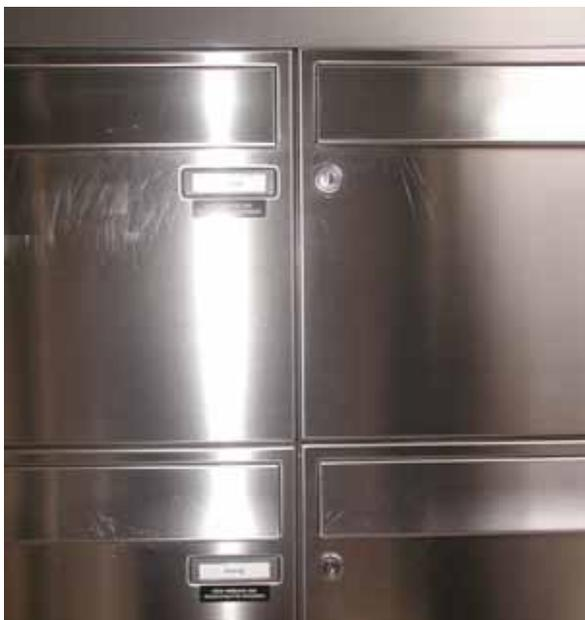
**Abb. 10:** Beispiel zerkratzter Oberflächen, Quelle: PLB Provinzial-Leben-Baubetreuungs-GmbH, Düsseldorf
