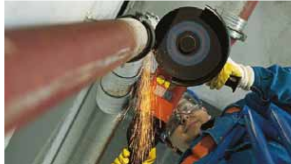
Abb. 13: Funkenbildung bei der Trennschneidarbeit, Quelle: http://www.infopool-bau.de
