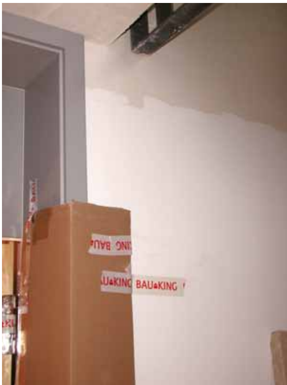
Abb. 12: Beispiel einer Abdeckung von Türzargen, Quelle: PLB Provinzial-Leben-Baubetreuungs-GmbH, Düsseldorf
