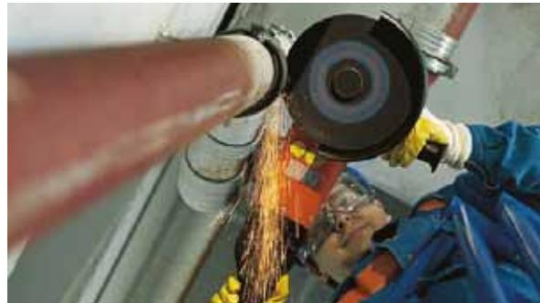
**Abb. 13:** Funkenbildung bei der Trennschneidarbeit, Quelle: <http://www.infopool-bau.de>
