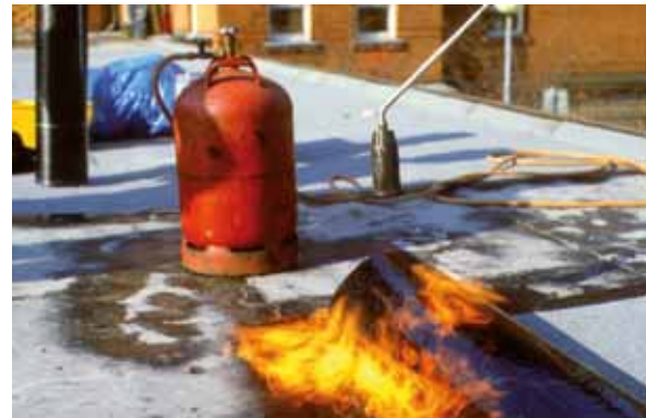
Abb. 1: Typische Zündquellen auf der Baustelle, Quelle: VdS 2216
