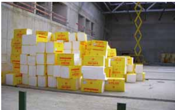
Abb. 3: Anhäufung brennbarer Stoffe auf der Baustelle, Quelle: D. Grüttjen
