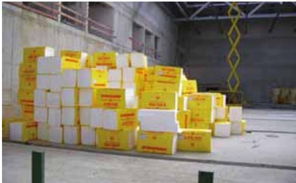
**Abb. 3:** Anhäufung brennbarer Stoffe auf der Baustelle, Quelle: D. Grüttjen
