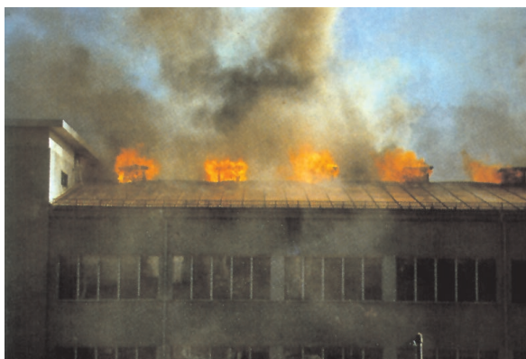
Abb. 2: Flammenüberschläge durch Dachdurchdringungen
