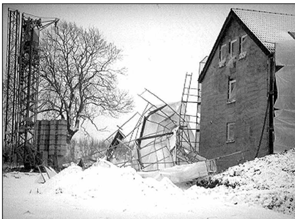
Abb. 4: Gerüste nach einem Wintersturm
