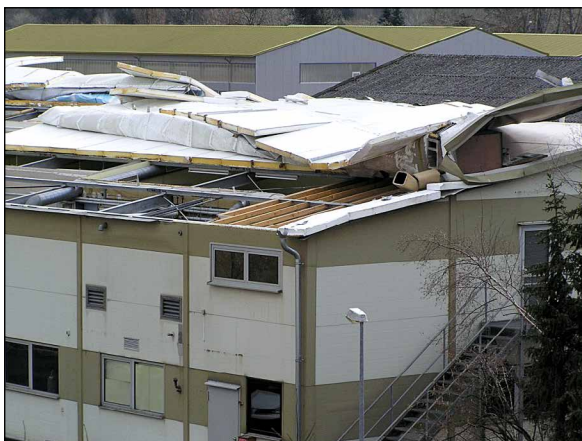
Abb. 9: Das abgehobene Dach (Quelle: HGI)
