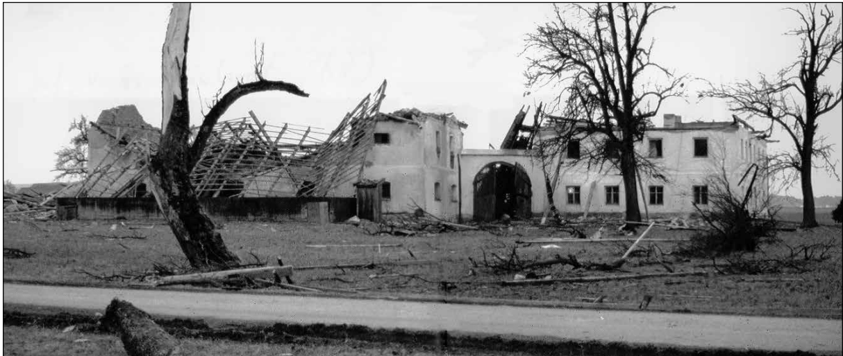
Abb. 2: Ein allein stehendes Gebäude nach einem Sturm
