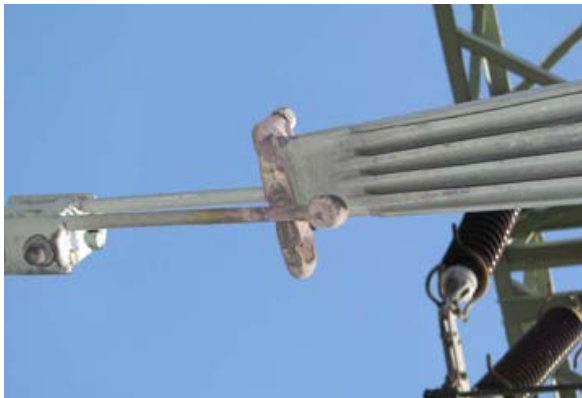
Auffälliger Trennkontakt am Sammelschienentrenner in der Hochspannungsanlage (Quelle: Michael Borchers)
