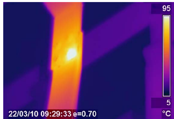
Auffällige Schraubverbindung an der 20-kV-Sammelschiene (Quelle: Michael Borchers)
