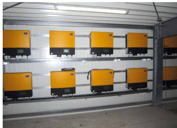
Bild 9: Wechselrichter auf nichtbrennbaren Untergrund
