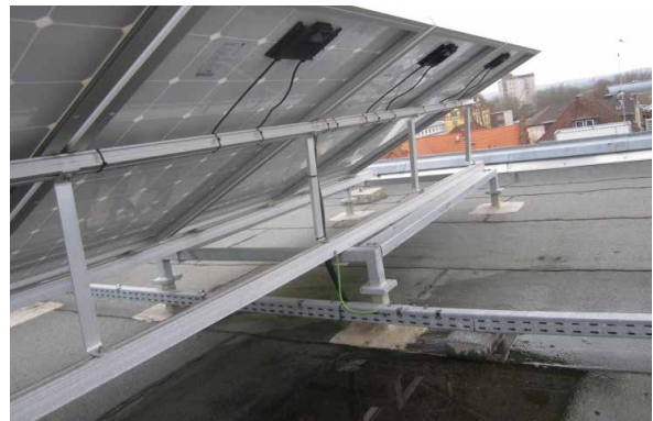
Bild 14: fachgerechte Leitungsverlegung
