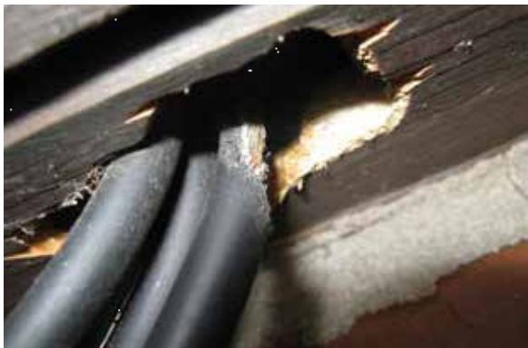
Bild 11 und 12: Beschädigungen von Leitungen
