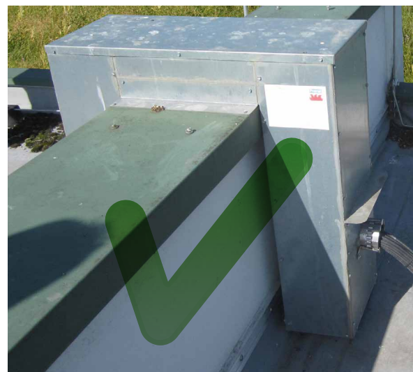
Bild 4: Verlegung von Leitungen über eine Brandwand mittels Brandschutzkanal
