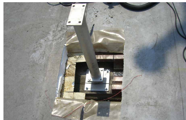
Bild 5: Einbindung Montagesystem
