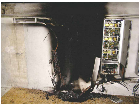
Bild 20: Brandschaden durch lose Klemmstelle an einem PV-Verteiler, aufgrund eines falsch eingelegten Gewindeplättchens, siehe rechts
