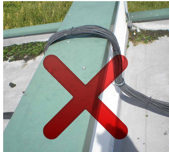
Bild 3: nicht erlaubte Verlegung von Leitungen über eine Brandwand
