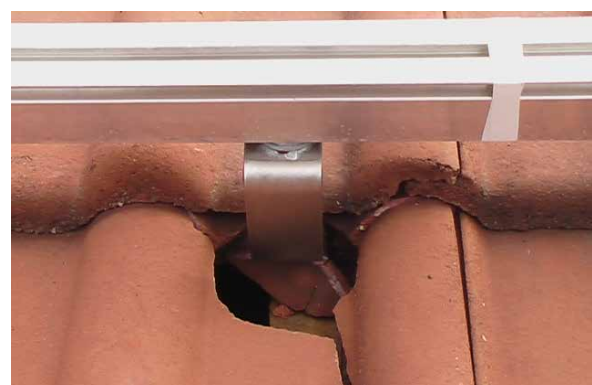
Bild 6: fehlerhafte Planung/Ausführung
