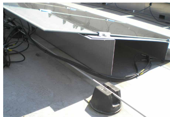
Bild 18: Abstand zwischen DC-Leitungen und Blitzschutzanlage nicht eingehalten (Trennungsabstand)
