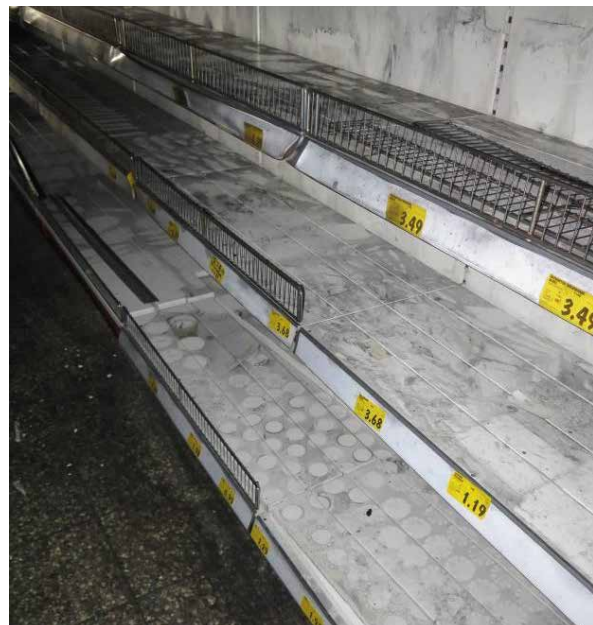
Bild 3-2: Schadenbeispiel Rauchschaden in der Lebensmitteldistribution; Bild zeigt Verkaufsgale nach Entsorgung der Ware.
