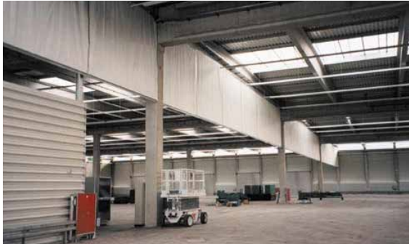
Bild 5-6: Zur horizontalen Begrenzung der Rauchausbreitung werden Rauchabschnitte durch abgehangte Rauchschürzen geschaffen (hier aus nichtbrennbaren Textilien).
