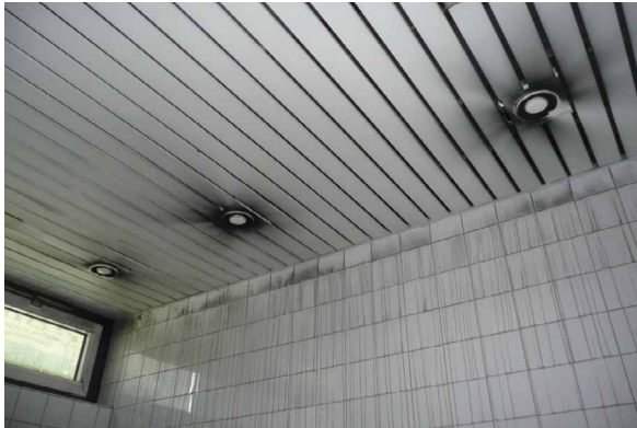
Bild 5-10: Über eine nicht abgeschaltete Lüftungsanlage wurde der Brandrauch in großen Mengen auch in vorher nicht vom Brand betroffene Nebenräume übertragen. (Bild: Brechler.Kiküm.Klein GmbH, Warendorf)
