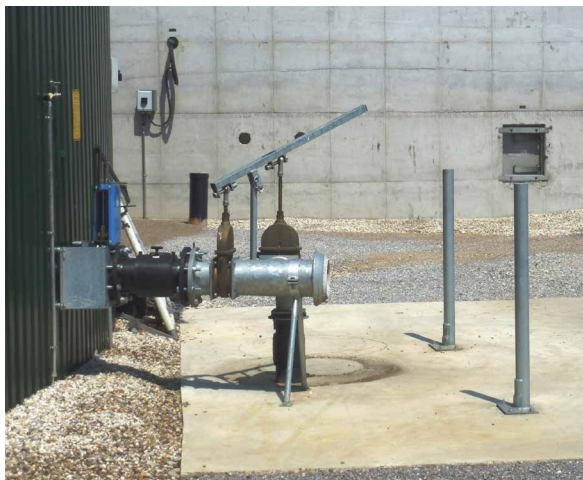
Bild 5: Doppelter Sperrschieber mit Sollbruchstelle
