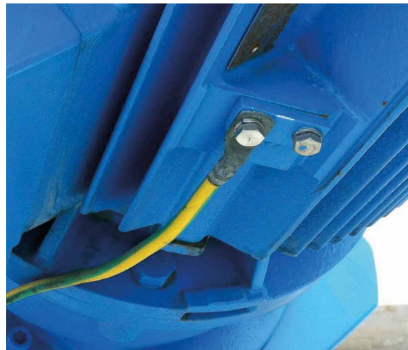
Bild 21: Potentialausgleich am Rührwerksmotor
