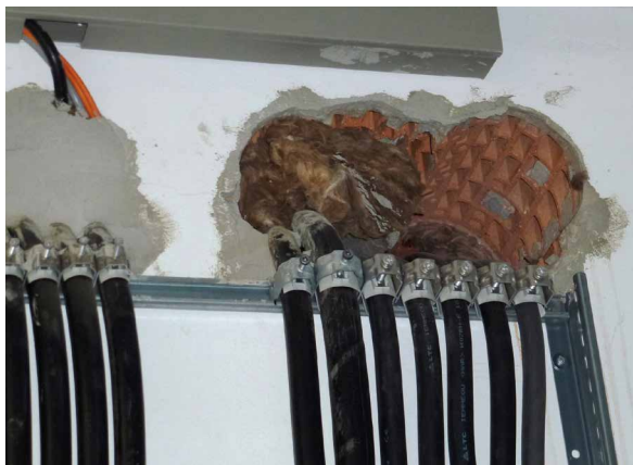
Bild 24: Mangelhafte Kabeldurchführung
