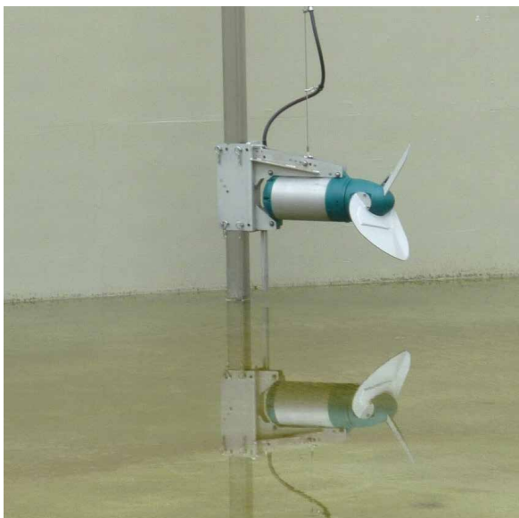
Bild 7: Tauchmotorrührwerk
