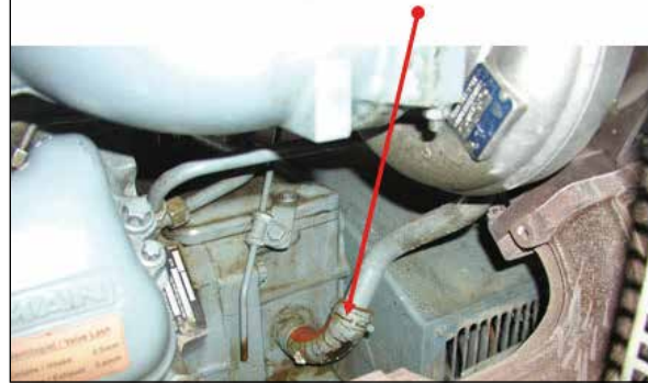
Bild 12: Thermisch überlastete Schmierölleitung
