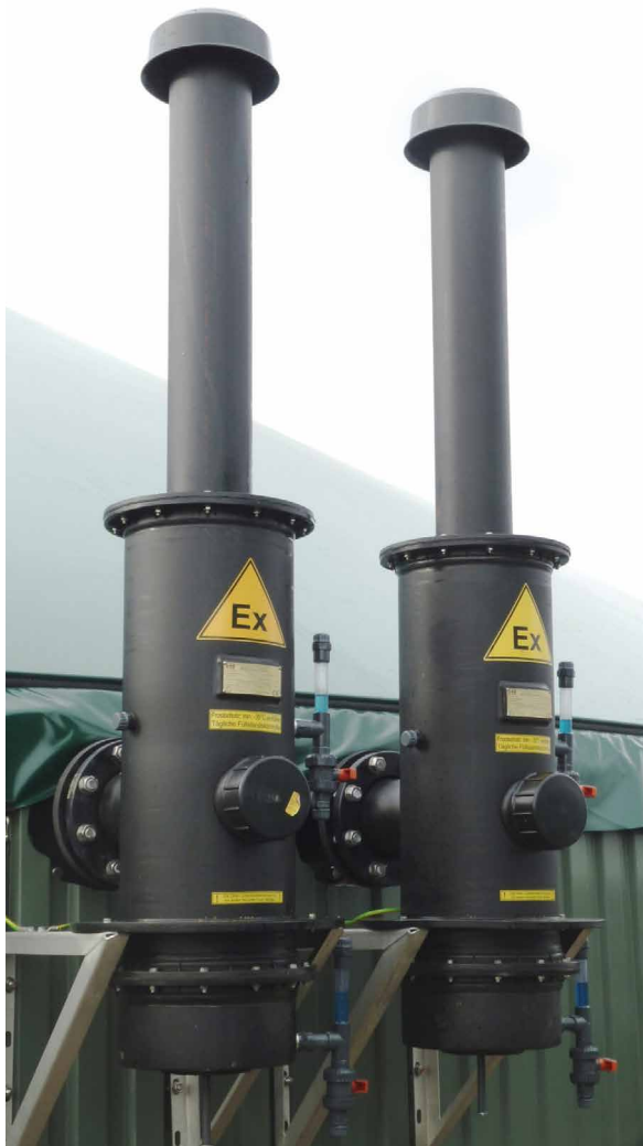
Bild 13: Überdrucksicherung
