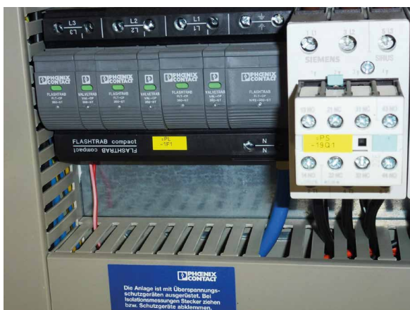
Bild 18: Überspannungsableiter
