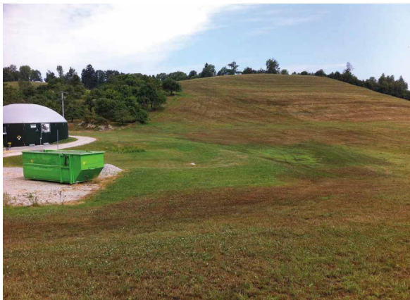
Bild 3: Biogasanlage am Fuß eines Hanges
