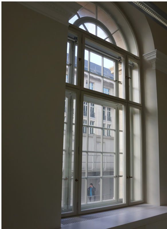
Bild 9-2: Kastenfenster, geschlossen
