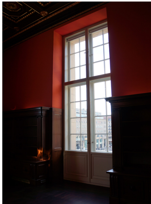
Bild 9-1: Zusatzverglasung bei historischer Bausubstanz
