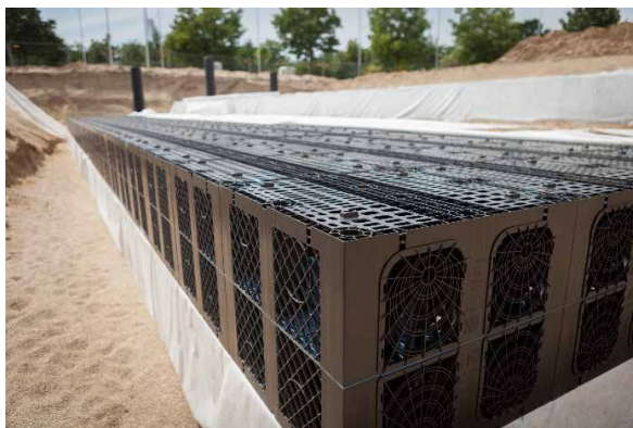
Abb. 8-24: Beispiel einer Versickerungsanlage (Quelle: Rehau)
