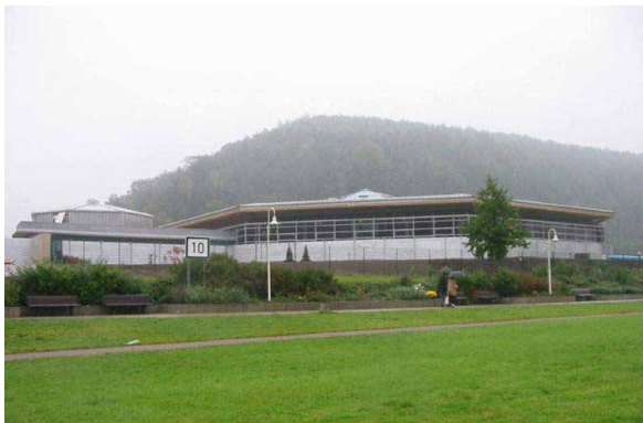
Abb. 8-16: Das Erlebnisbad mit aufgebautem Hochwasserschutzsystem (Quelle: RS Stepanek OHG)
