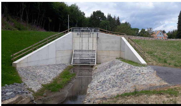
Abb. 8-29: Durchlassbauwerk, Blick talab (Quelle: W. Schleiner)
