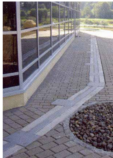
Abb. 8-18: Bodenschienen mit Ankerplatten für das Hochwasserschutzsystem (Quelle: RS Stepanek OHG)
