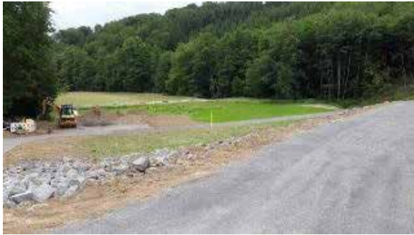
Abb. 8-27: Dammkrone zwischen den Flanken des Jabachtals, Blick talauf (Quelle: W. Schleiner)
