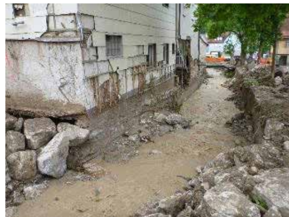
Abb. 6-2: Beschädigtes Gebäude in Braunsbach (Quelle: Adrian Riemer, Universität Potsdam)
