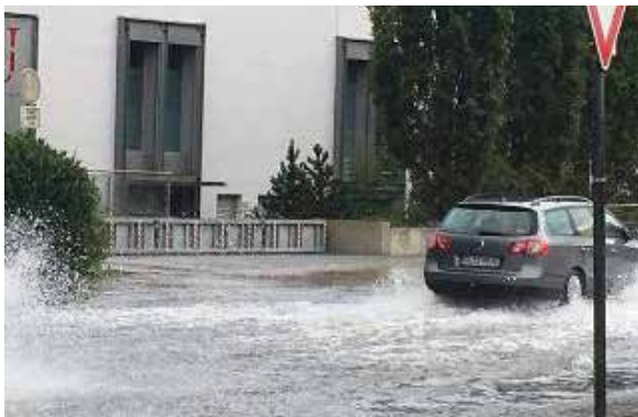
Abb. 8-12: Wasserüberstau vor der Einfahrt in der Visbeker Straße nach der Aktivierung des Automatikklappschotts (Pos. 22 in Abb. 8-10) (Quelle: Johanneum)
