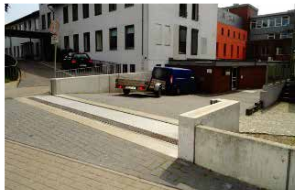
Abb. 8-9: Krankenhauseinfahrt (siehe auch Abb. 8-10, Pos. 22, Quelle: R+V Versicherung)
