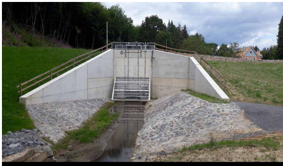
Abb. 8-29: Durchlassbauwerk, Blick talab (Quelle: W. Schleiner)
