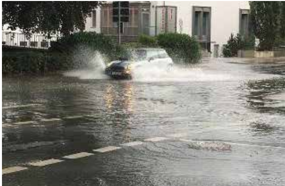
Abb. 8-11: Wasserüberstau vor der Einfahrt in der Visbeker Straße kurz vor Aktivierung des Automatikklappschotts (Pos. 22 in Abb. 8-10) (Quelle: Johanneum)
