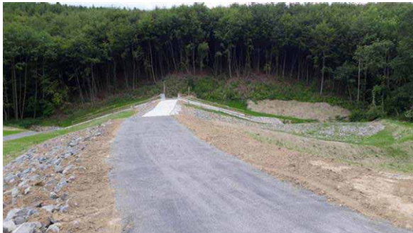
Abb. 8-28: Dammkrone zwischen den Flanken des Jabachtals, mit Notüberlauf und Durchlassbauwerk (Quelle: W. Schleiner)
