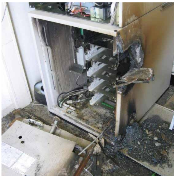
Bild 3-5: Türöffnung nach Brennschneiden
