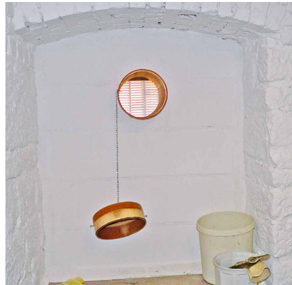
Abb. 5: Beispiel für Lüftungskappen (Quelle: R+V Allgemeine Versicherung AG)
