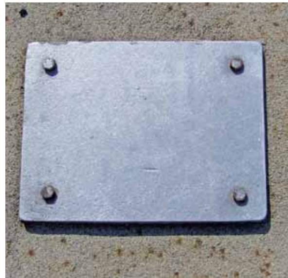
Abb. 24: Aufgeschraubte/verschraubte Deckel für Schächte mit Abdichtung (Quelle: Klaus Dieterle)
