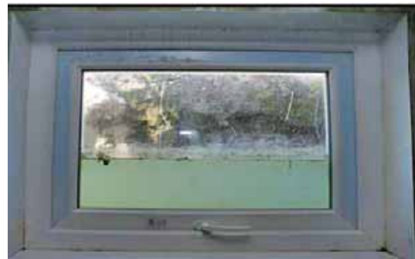
Abb. 8: Beispiel für ein wasserdicht ausgeführtes Fenster (Quelle: Modell Neptun Outside, Alpina Hochwasserschutzfenster GmbH, www.alpinafenster.de )
