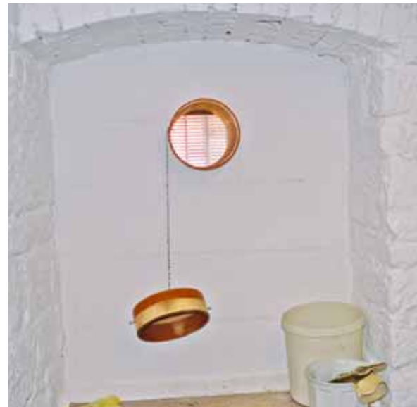
Abb. 5: Beispiel für Lüftungskapfen (Quelle: R+V Allgemeine Versicherung AG)
