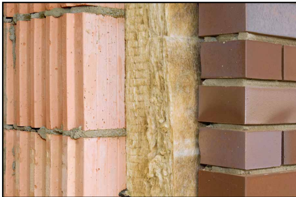
Abb. 5: Zweischaliges Mauerwerk mit Kerndämmung (Mineralwolle) (© HTW Dresden)
