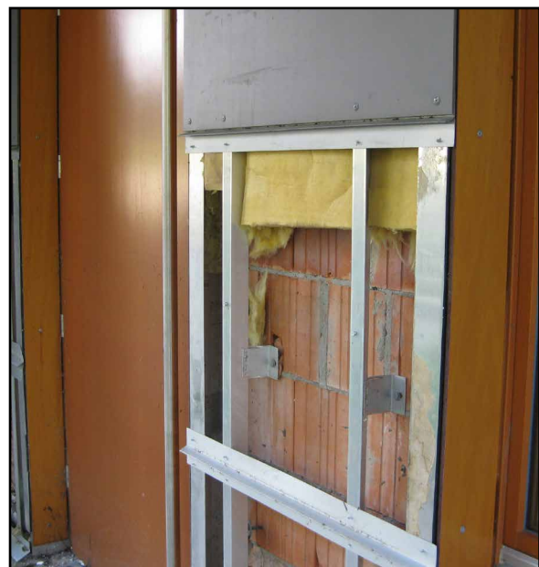
Abb. 6: Vorgehängte hinterlüftete Fassade (© HTW Dresden)
