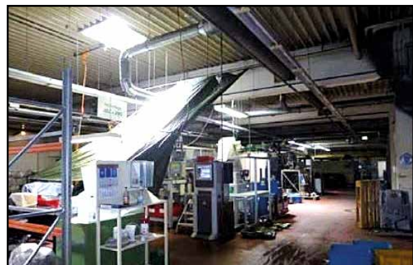
Abb. 22: Mit Folie gegen eindringendes Regenwasser geschützte Maschine und Einrichtungen (Quelle: HDI)
