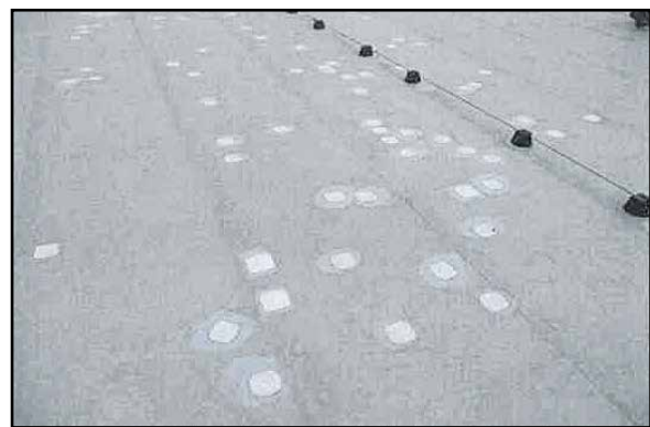
Abb. 6: Ausgebesserte Schadstellen in der Dachabdichtung (Quelle: R+V)
