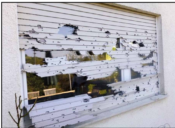
Abb. 8: Von Hagel zerstörter Rollläden aus Kunststoff (Quelle: R+V)
