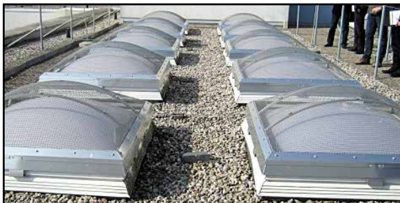
Abb. 23: Hagelschutzgitter für Lichtkuppeln (Quelle: VGH)
