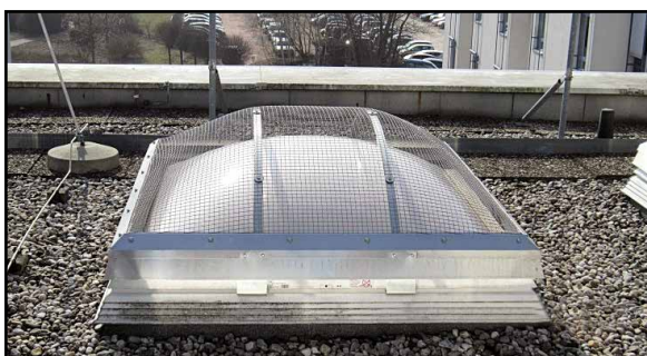
Abb. 24: Detailansicht eines Hagelschutzgitters (Quelle: VGH)
