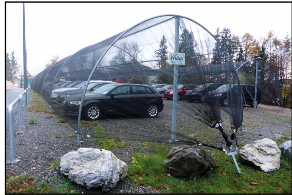
Abb. 25: Hagelschutznetz (Quelle: R+V)
